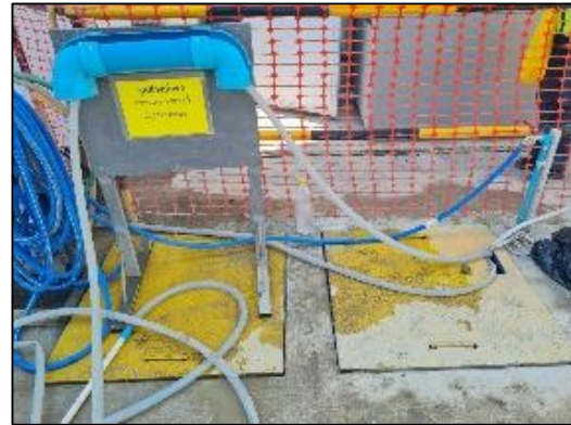
ภาพที่ 18 ระบบล้างล้อรถอัตโนมัติแรงดันสูง
