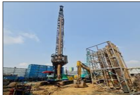
ภาพที่ 20 เส้าเข็มเจาะ
